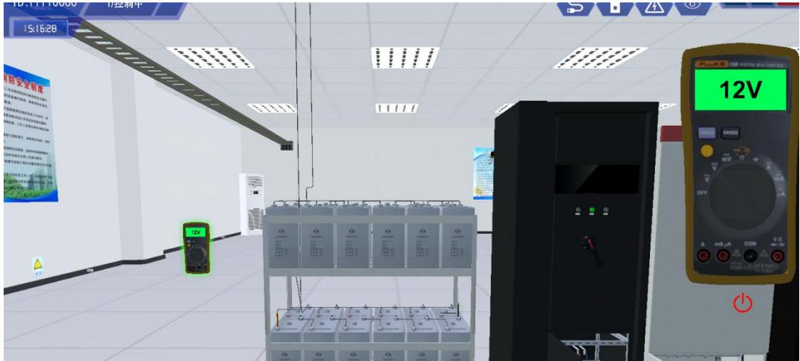
图 2.5.5.2 万用表测量电压
