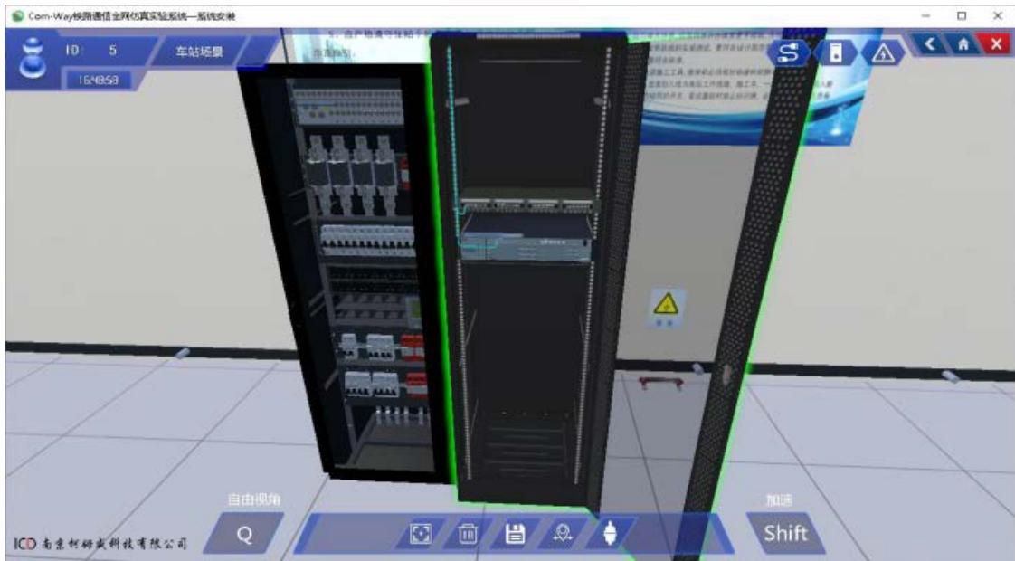
图 5.5.3 站点机房设备
