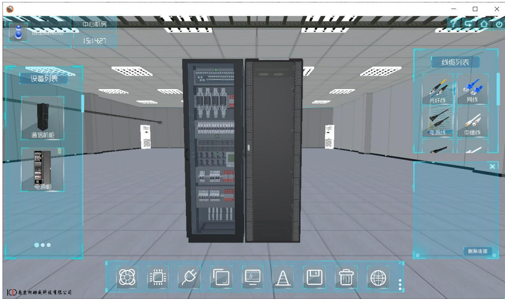
图 7.7 电源柜与机柜安装
